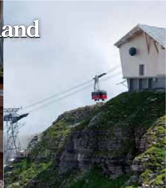
TRUTZIG Die neu errichtete Bergstation des während des Baus Zeichen – alle Materialien
